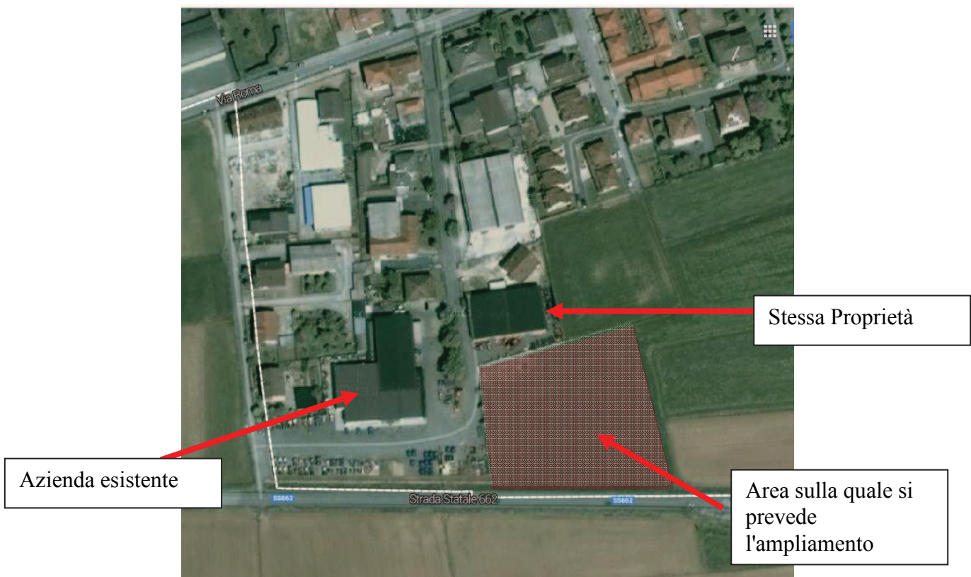
Figura 20 - Foto aerea con indicazione dell'insediamento oggetto di Variante (Fonte: Google Earth)
