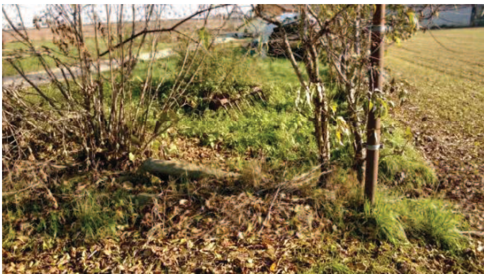
Figura 29 - Foto del tratto di prosecuzione del tratto soppresso verso est (alveo inesistente)
