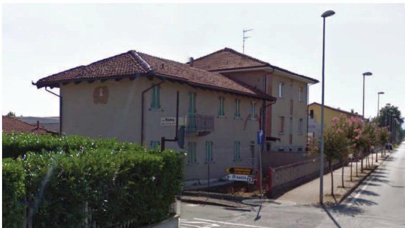
Figura 15 - Foto dei fabbricati residenziale indicati con la lettera B nella Figura 18
