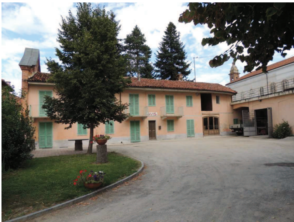
Figura 2 - Prospetto su cortile interno del fabbricato principale
